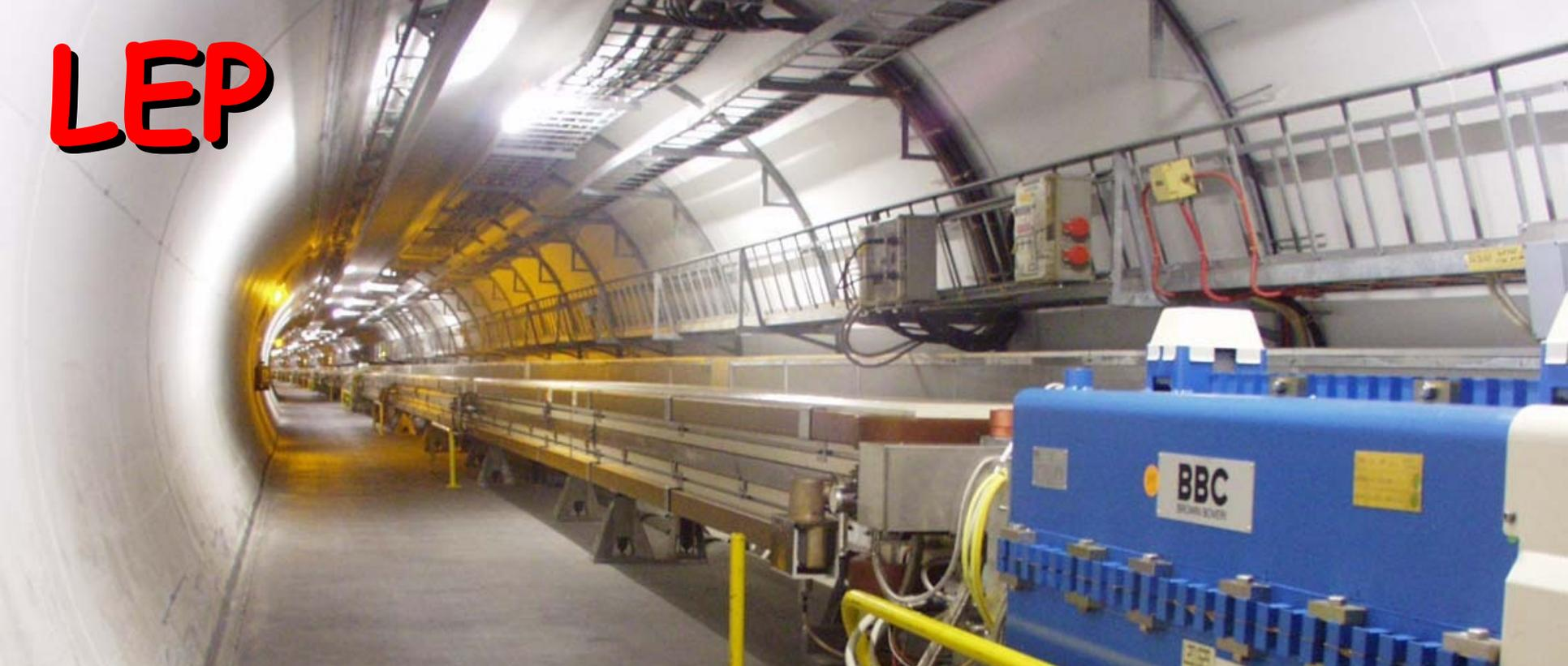
Dal 1985 al 1988 furono scavati 1.4 milioni di metri cubi lungo 27 km ad una profondità di oltre 100 metri
